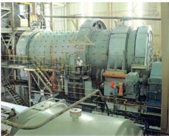
SAG Mill Deelkraal Gold Mine, South Africa (4,9 m 12,2 m dia.)
